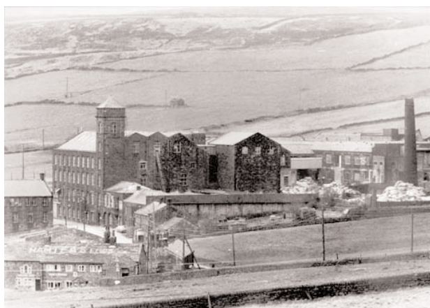
Foto 3: vista de la planta de la Cape Asbestos en Acre Mill (Yorkshire) hacia 1970. Esta es la planta en la que trabajó Alice Jefferson
